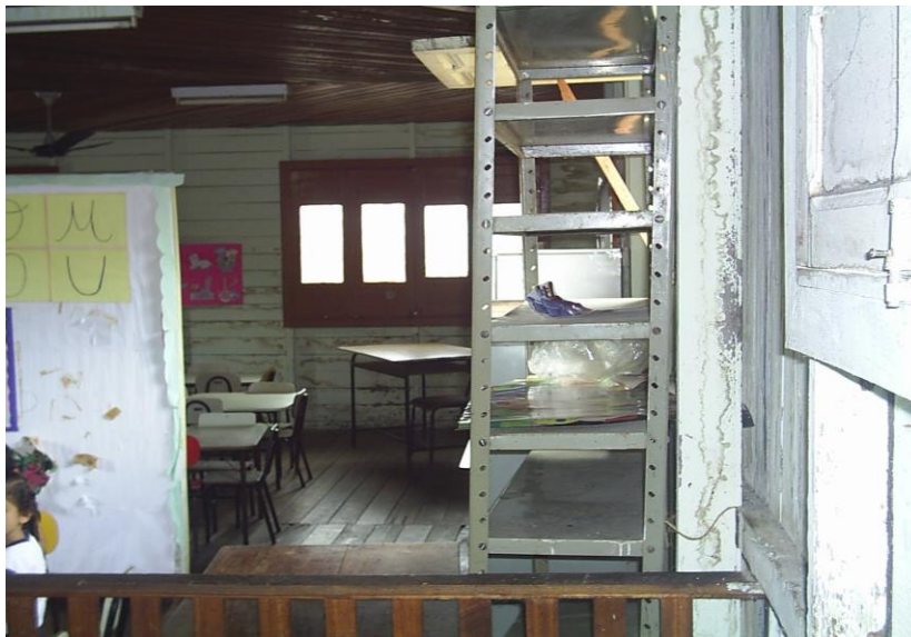
Figura 8: Anexo de madeira. Fonte: Lopes, 2006.
