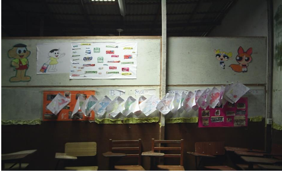
Figura 7: Parede e divisória das salas feita com compensado Fonte: Lopes,2006.
