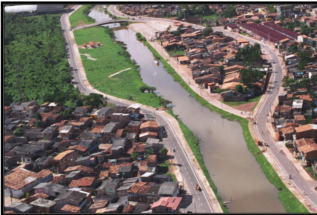
Foto 3: Vista aérea da área da ocupação Pantanal à margem do Igarapé Tucunduba. Fonte: PMB (2003).
