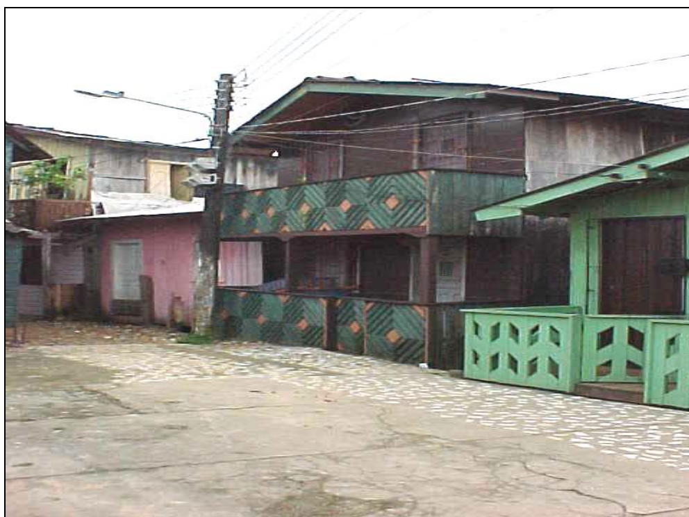
Foto 14 - Vila da Barca – Casa com varanda. Fonte: SEHAB, 2004.
