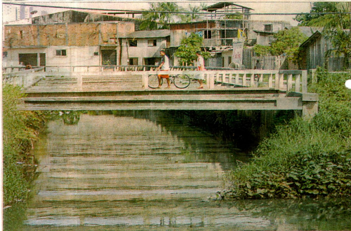
INFRA-ESTRUTURA ■ Falta de saneamento básico e esgoto também é um dos graves problemas enfrentados pelos moradores do bairro do Telégrafo
