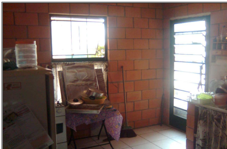
Foto 25 Vila da Barca – Casa com Infiltração. Fonte: Pesquisa de Campo - 2010
