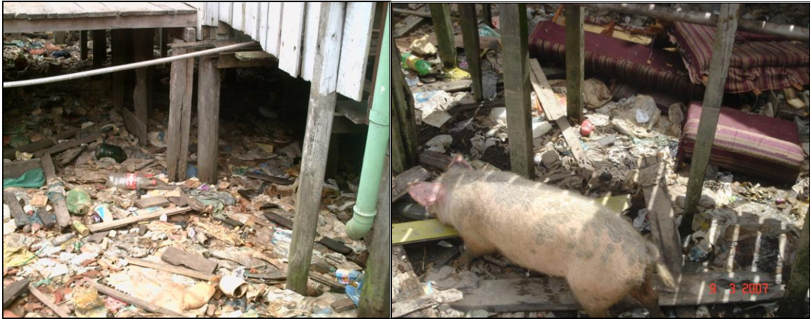
Foto 28 e 29 - Vila da Barca – Lixo acumulado. Fonte: SEHAB, 2007
