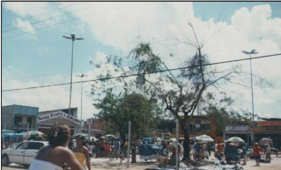
Figura 28 - Reforma de cercamento da praça.
