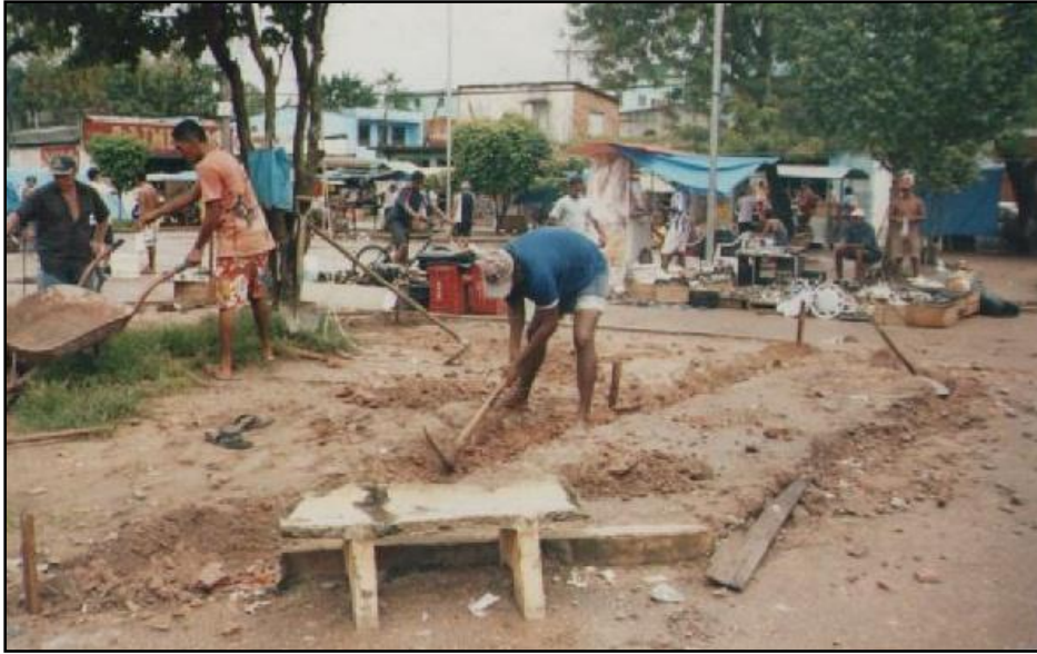
Figura 27 - Reforma de cercamento da praça.
