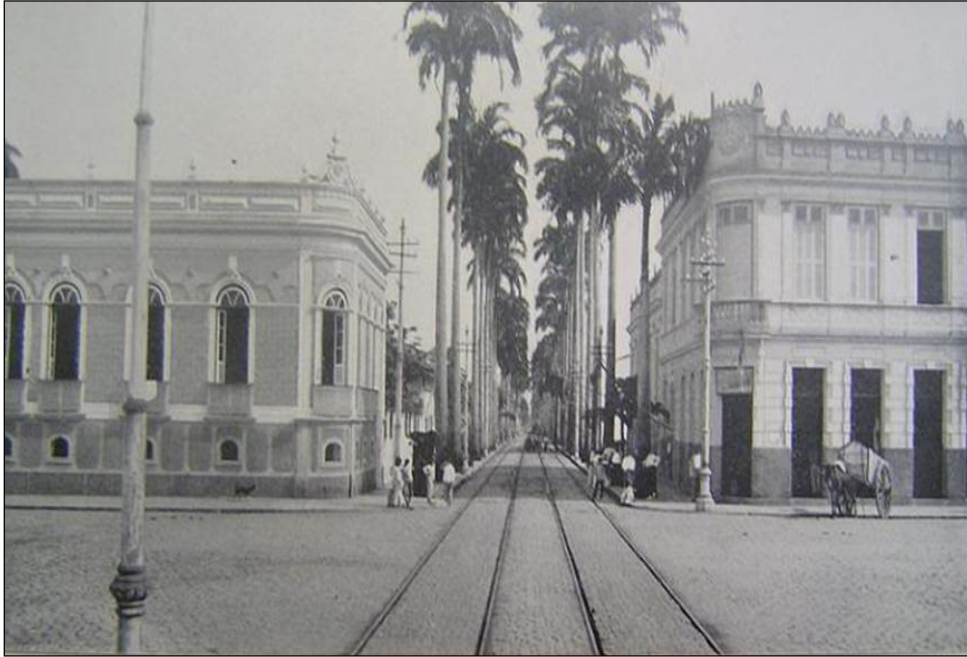
Figura 9 - Av. 16 de Novembro, no bairro da Campina após reforma realizada por Antonio Lemos.
